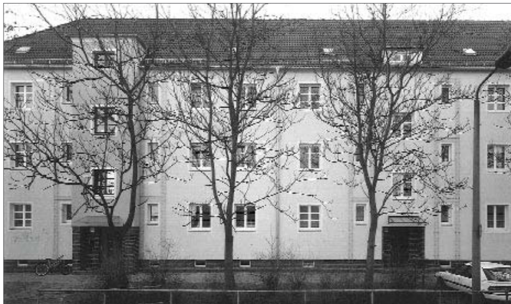
Sanierte Gebäude der HWB in der Berliner Straße.
