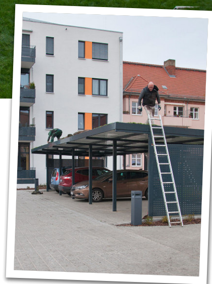
Dachgarten für Autos. Die Dächer der beiden Carports wurden begrünt.
