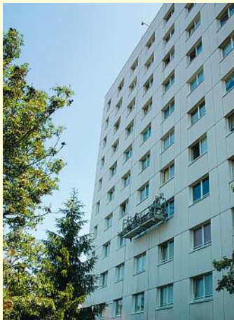
Fassadenreinigung. Die Reinigungskräfte seiteln sich mit einer Arbeitsplattform ab.
