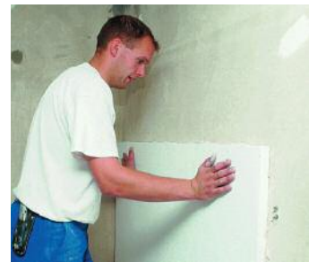
Multivalent. Dämmplatten aus Kalziumsilikat helfen Energie zu sparen, schützen vor Schimmelbefall und lassen sich auch sehr gut und schnell verarbeiten.
